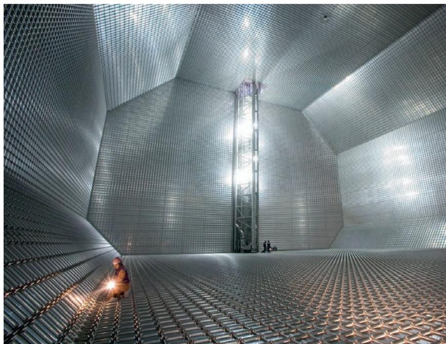
**Créées par GTT, les technologies dites « à membranes » sont nées de l'idée de réduire les coûts du transport maritime du GNL en le chargeant, en vrac, dans les cales du navire.**
